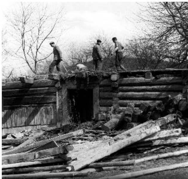
Demontáž Blinky chalupy v Horní Bečvě tesařskou skupinou z Velkých Karlovic, 1964
