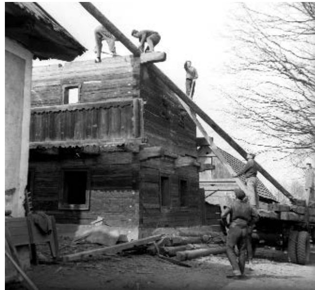
Demontáž stavby fojtství v Lidečku, 1968
